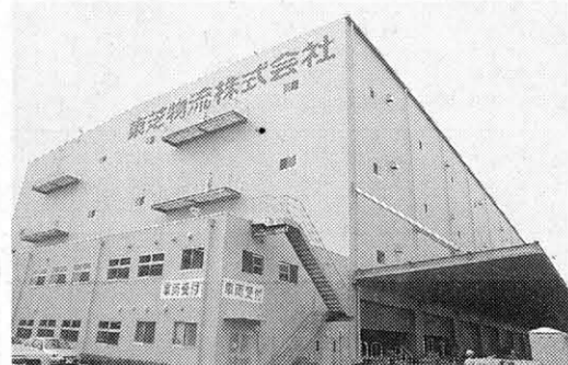
完成間近な物流倉庫の現況
