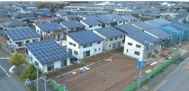
▲昨年11月に現地をドローンで上空から撮影した様子
