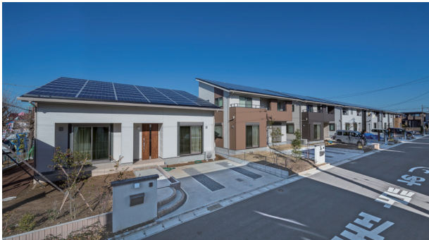
▲完成イメージパースと同アングルで撮影した分譲地の様子
