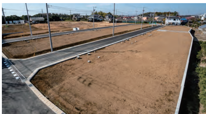
広大な敷地を分譲用地として造成
