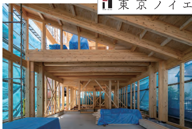
東京ノイエでは木造で大空間を実現できる「ストローク工法」を採用
