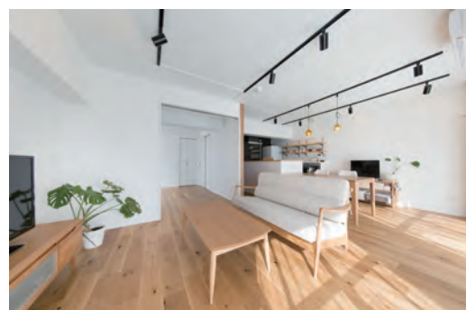
バリアフリーにするため床の高さを上げた分、二重天井をコンクリートのむき出しにし、塗装で仕上げました。
